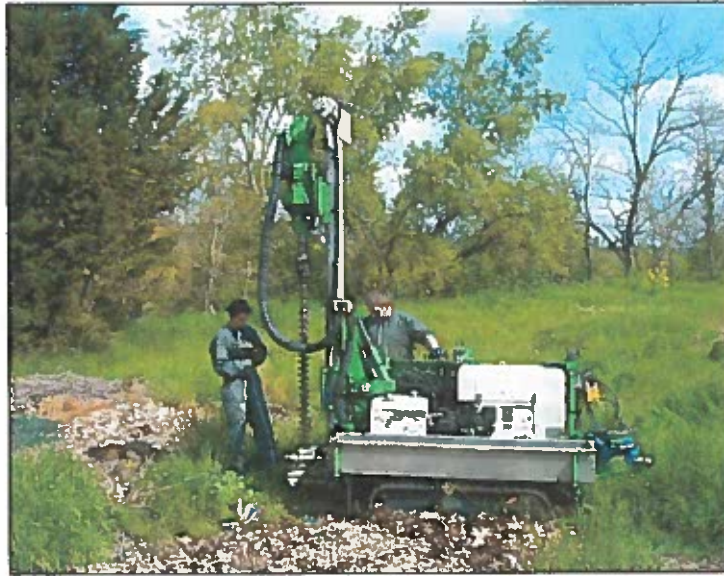
Figure n°21 : Sondages à la tarière mécanique. (TEC.04.074.TERRAF (RA.002.1).021.1)
